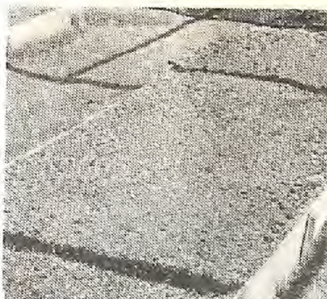
O bom preparo do solo é de vital importância para o funcionamento de produtos químicos desinfetantes
