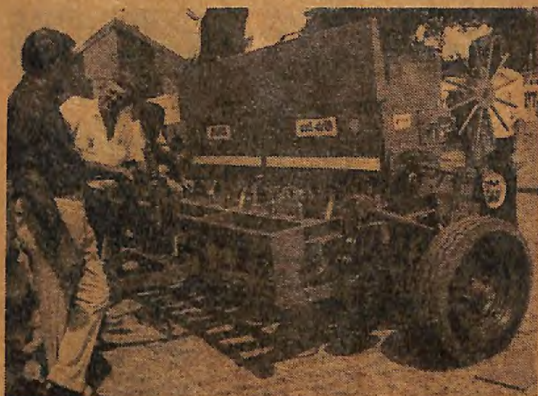
Esta semeadeira Moore Uni-drill, tem ação direta e espaçamento reduzido entre sulcos. É indicada para trabalhar em pastagens, plantações de cereais, etc. Funciona em qualquer terreno e é ideal para terras áridas, porque planta sem remover a camada superior do solo e não deixa escapar a umidade
