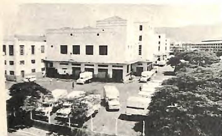
Usina Central (Rio de Janeiro-GB)
