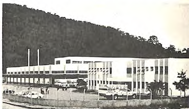
Fábrica Eduardo Duvivier-FAED (São Gonçalo-RJ)
