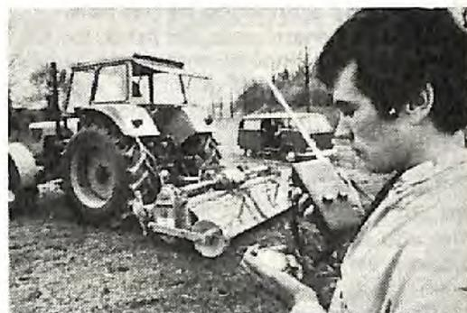
Um cultivador com cavadoras giratórias está sendo testado em diversos tipos de solos, para medir a sua potência e capacidade de rebocar. Um rádio transmite os resultados até à perua, ao fundo
