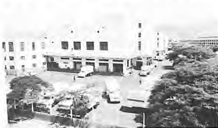
Usina Central (Rio de Janeiro-GB)
