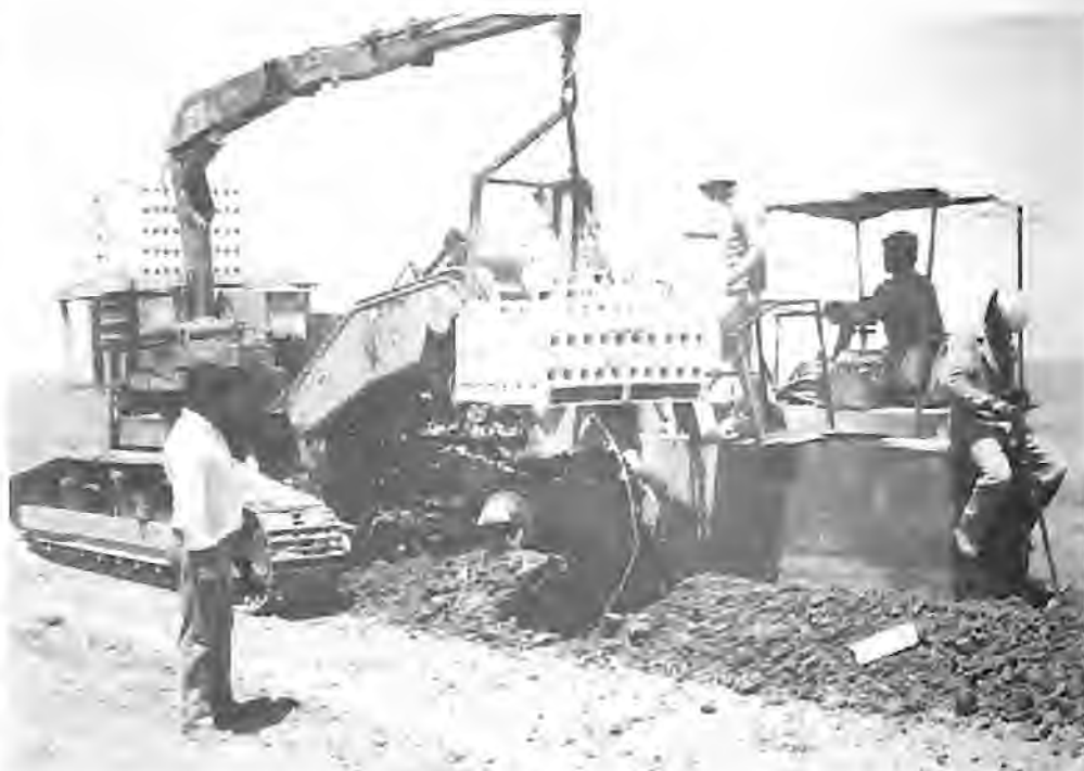
Esta máquina funciona na colocação de drenos enterrados.
