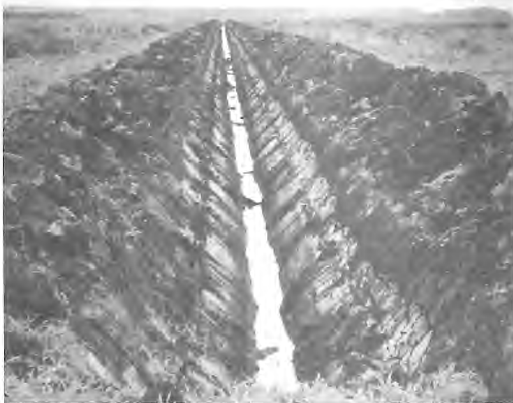
Dreno para drenagem superficial e sub-superficial.
