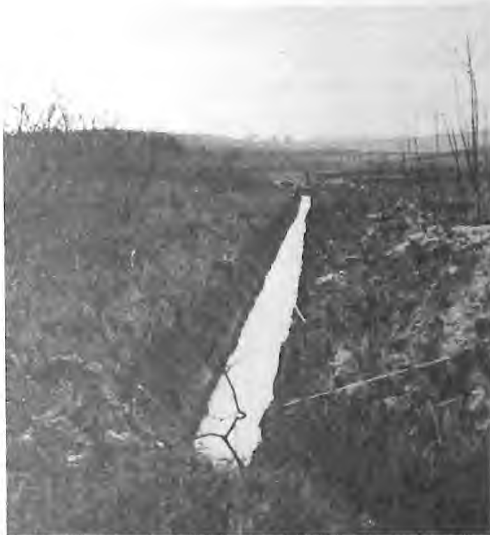
Vista de um dreno de encosta.
