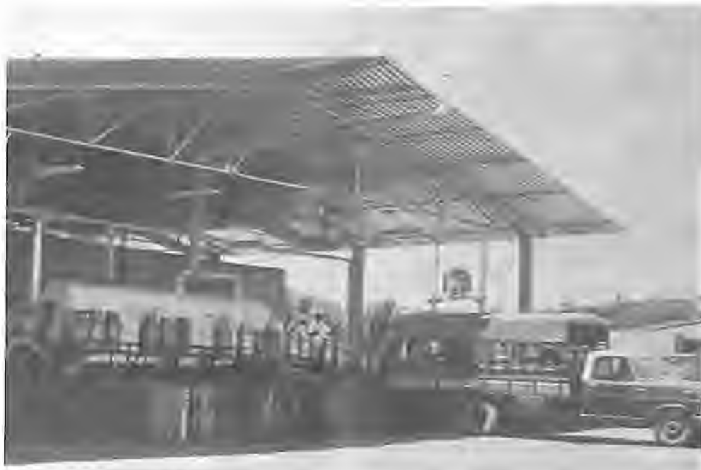
Plataforma de um posto de recepção do interior
