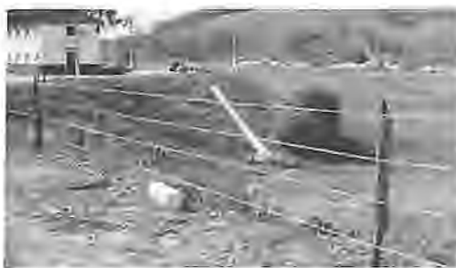
Cerca de arame farpado com balancim, substituindo os moirões
