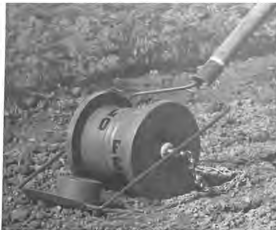
A semeadeira manual deposita a quantidade ideal de sementes — 1,3 quilogramas por hectare
