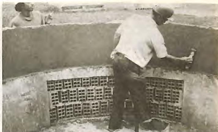
Detalhe do acabamento do secador mostrando a passagem do ar do duto para o tanque secador.
