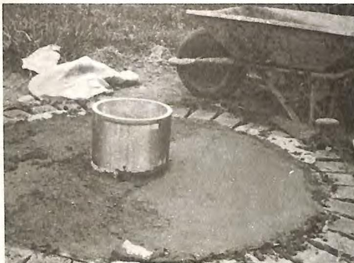
Detalhe da fundição da tampa do ciclone, mostrando a confecção da tomada de ar quente.
