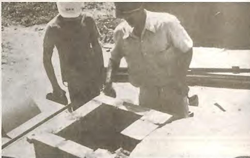
Detalhe do acoplamento da fomalha com a ventoinha, mostrando a tampa do ciclone já colocada.
