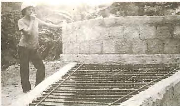
Detalhe da construção do duto de conexão do ventilador com o tanque secador.
