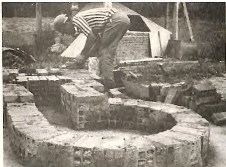
Início de construção do ciclone, com detalhe da passagem do ar da fornalha para o ciclone.
