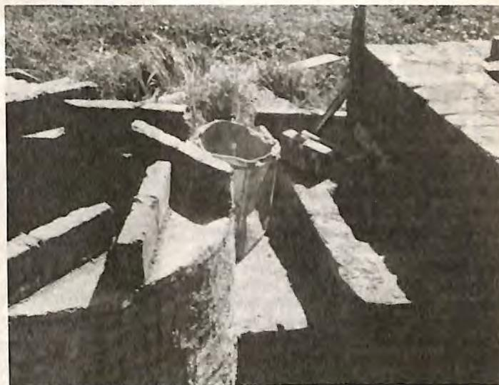
Detalhe do posicionamento dos tijolos superiores para provocar o turbilhamento do ar no ciclone.
