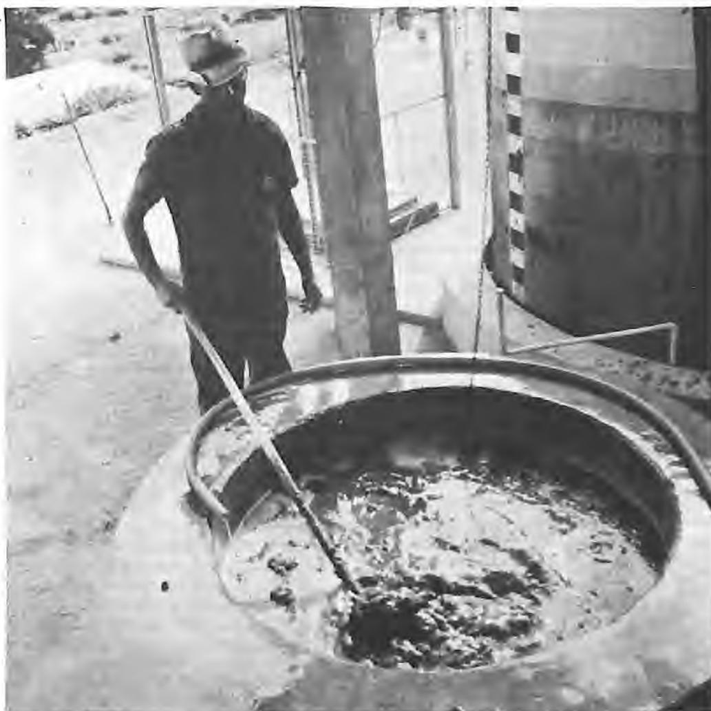
Preparação da mistura de esterco e água antes de ser introduzida no biodigestor.
