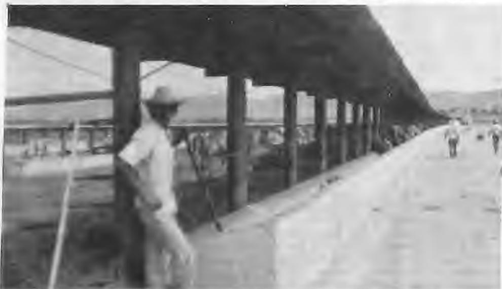
Cocho de alvenaria coberto de telha de amianto e estrutura de madeira. Observar localização do cocho em relação aos pilares.
