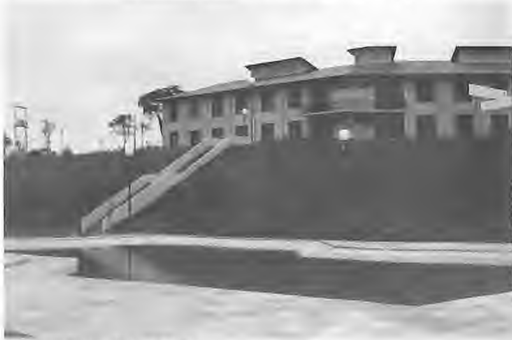
Vista parcial da piscina e do edifício-sede
