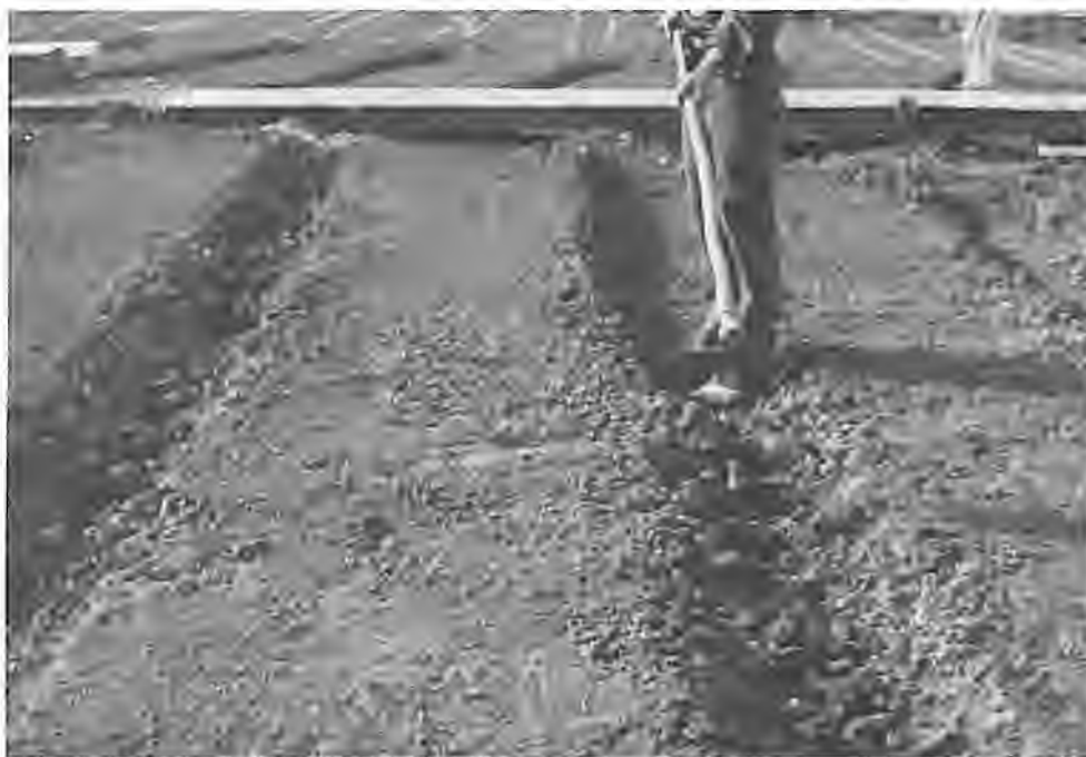
Preparo do canteiro
