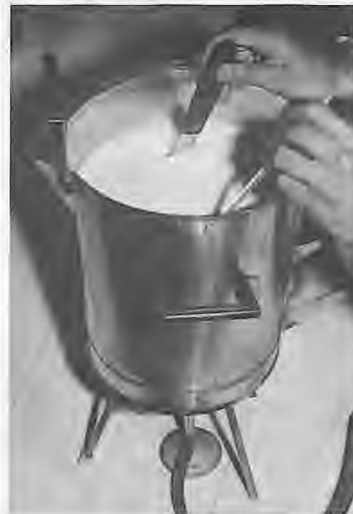
Proceder o aquecimento do leite sob constante agitação a uma temperatura de 62°C–65°C por 30 minutos. Em seguida resfriá-lo a 35°C.
