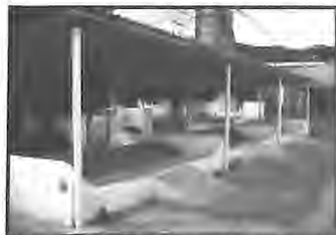
Cada módulo do terreiro secador deve medir 10,0 x 15,0 m
