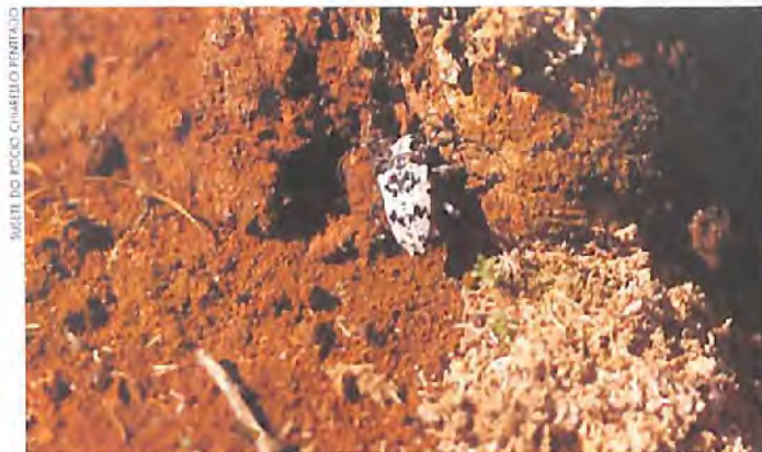
Serragem expelida que denuncia a presença do ataque da broca-da-erva-mate
