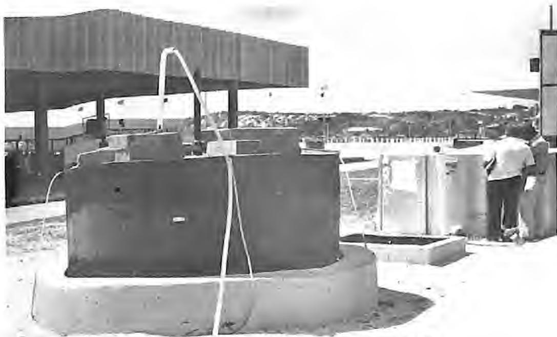
Digestor convencional fabricado pela Emater-BA, que movimentava um motor e gerava energia elétrica no recinto da Expo. Bahia/80.
