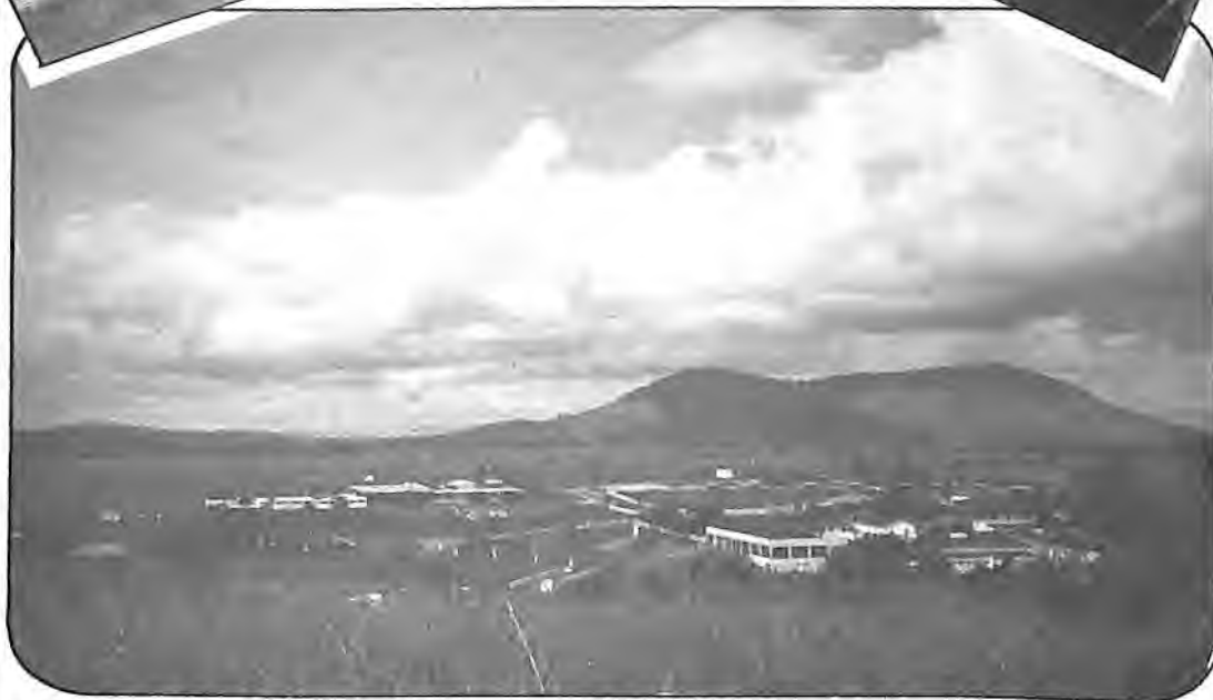
A CABANA DA PONTE está de roupa nova, com diversas instalações dentro dos mais rígidos padrões internacionais.
