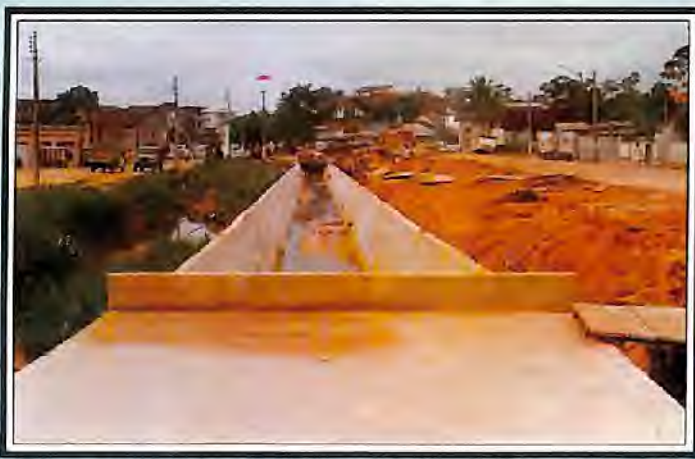
Igarapé Rodrigues Alves durante as obras de concretamento.
