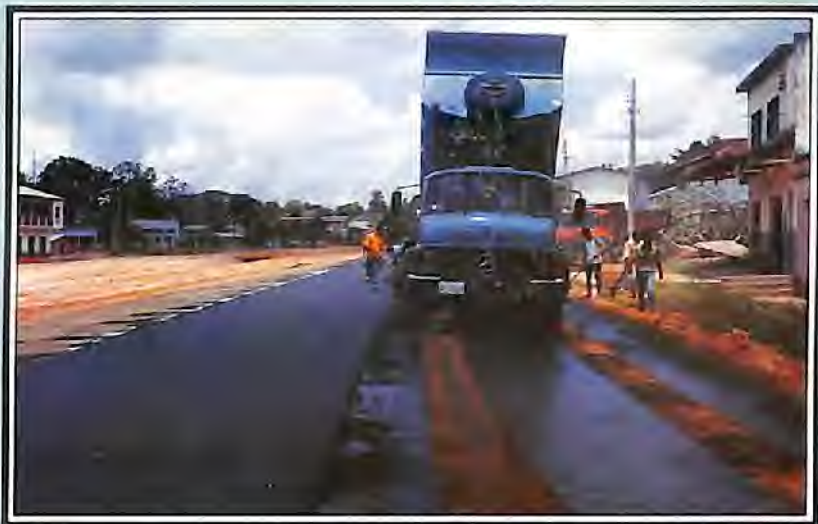
Obras de asfaltamento no centro da cidade. Já concluídas.
