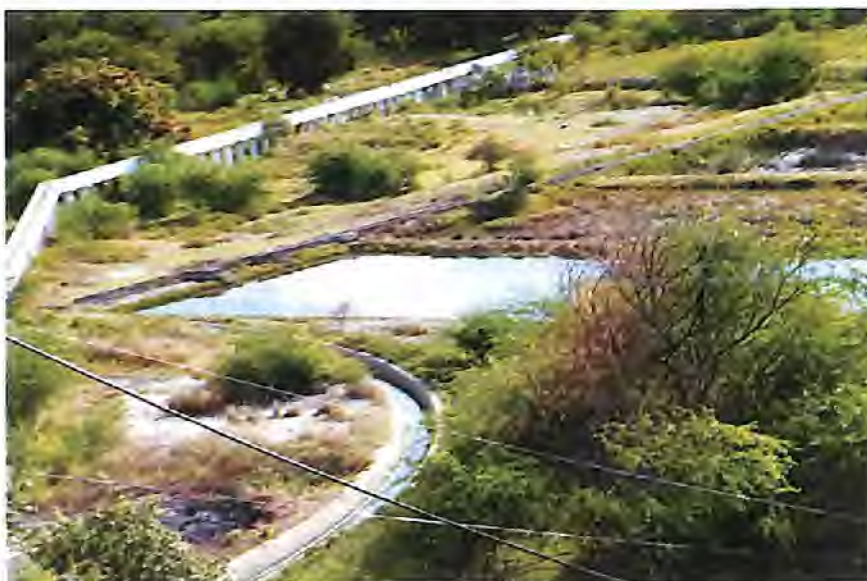
Adutora construída durante o Brasil Imperial.
