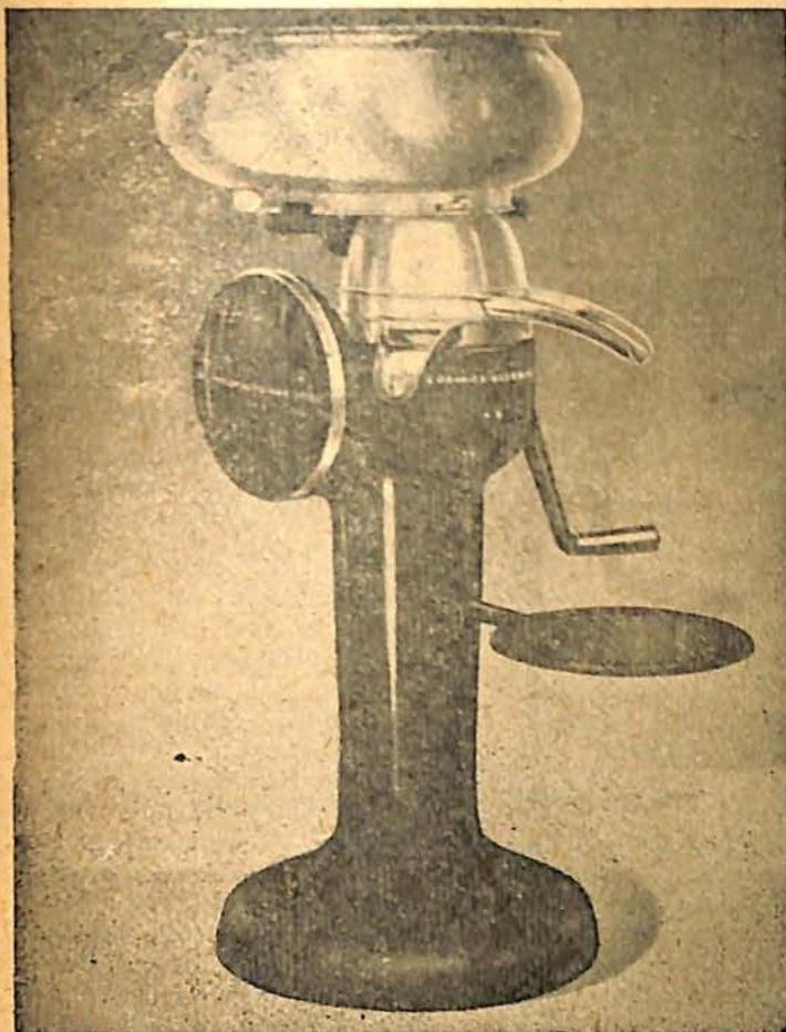
Tivemos, durante algum tempo, forçados pelas dificuldades de importação, esgotado o nosso estoque dessas desnatadeiras que, por uma série de atributos, se tornaram preferidas junto à nossa clientela. Fabricada em 4 tamanhos — 227, 340, 454 e 567 lts. por hora — a "INTERNATIONAL" tem o mecanismo fabricado com material de 1.ª qualidade montado sobre 4 rolamentos de esferas, sendo a sua lubrificação automática caprichosamente estudada.
