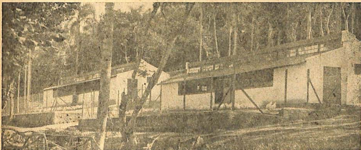
Vista de galinheiros para poedeiras (tipo semi-monitor) para 300 poedeiras Leghorn Branca, com parques simples. Notar que os parques são um pouco mais extensos que os abrigos. (Granja Guarulhos — São Paulo).
