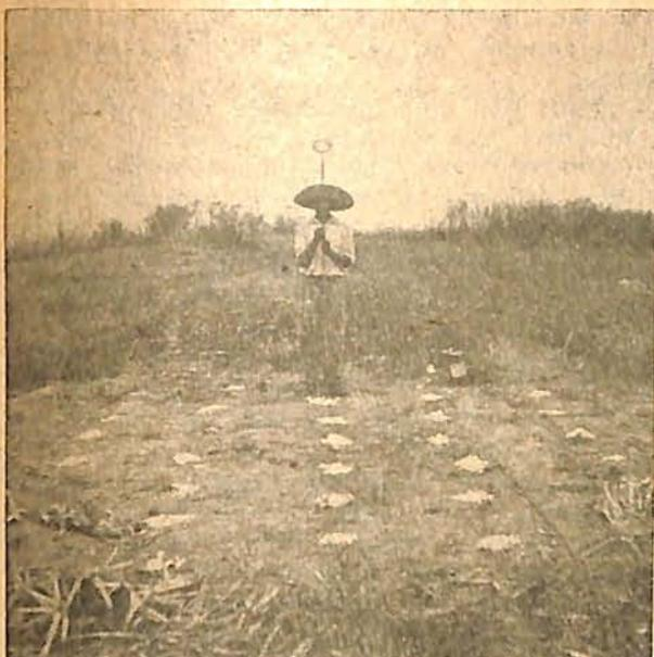
Início do ataque a um formigueiro velho (Praça). As marcas brancas foram feitas a cal para destacar, na fotografia, os pontos de introdução na sonda. Foto do autor.
