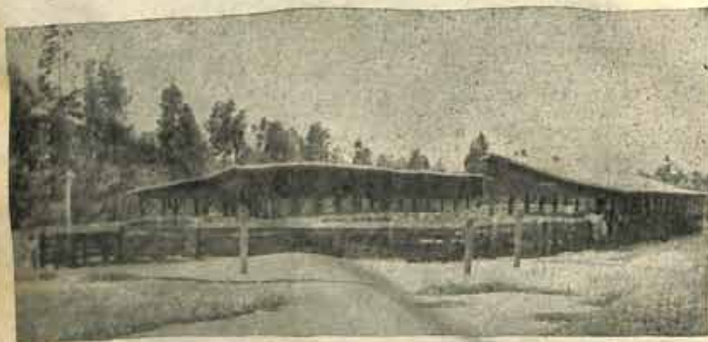
Vista das instalações onde se realizaram as primeiras provas de alimentação de gado bovino, visando à produção de carne
