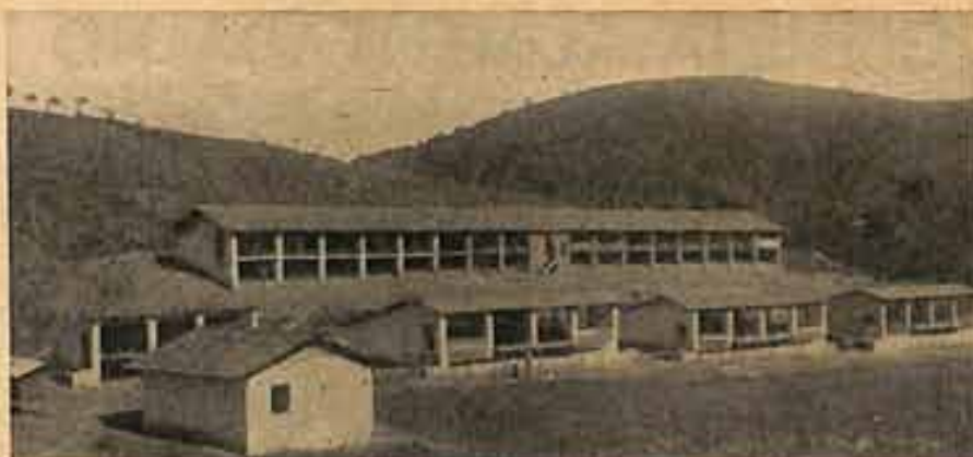
Vista de um grupo de «estaleiros» com piso de sarrafos, elevado um metro do chão. Os «estaleiros» desse tipo recebem os pintos com 6-8 semanas, criados em pinteiros com piso telado. É um tipo de produção de frangos que encontra muitos animadores em nosso meio avícola. Fotos da Granja Santo Antônio, em Mairiporã.
