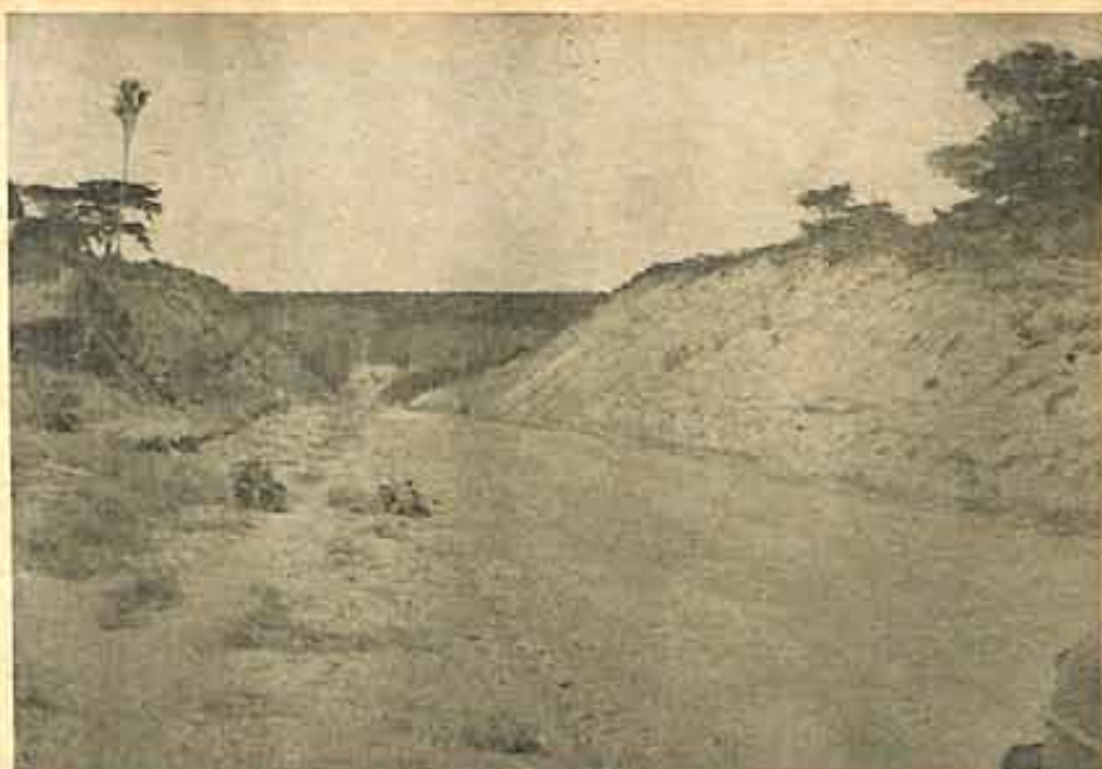
Trêcho recém-concluído da Br-14, Goiânia-Itumbiara, vendo-se parte de um pequeno corte dessa importante estrada.
