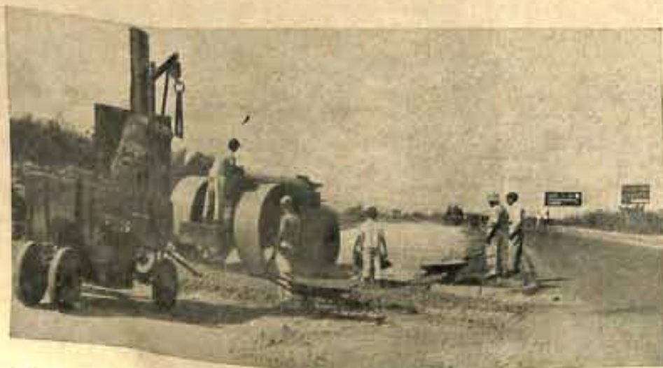
Serviço de asfaltamento da Go-4, Goiânia-Goiás-Aruanã, vendo-se um trecho construído em duas vias, ainda dentro do perímetro urbano, na ligação entre o centro da capital e o bairro de Campinas.
