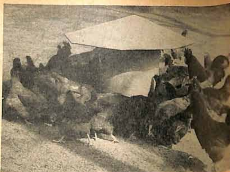
Comedouro automático cilíndrico de fibro-cimento "Brasilit" instalada no Aviário do Departamento de Produção Animal - Parque da Água Branca, na criação a campo. Note-se o "colar" de galinhas e galos atacando seguidamente a farelada do comedouro.
