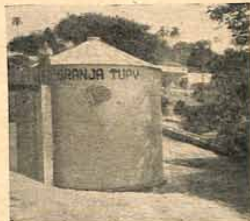
Silo metálico para 93 toneladas de milho
