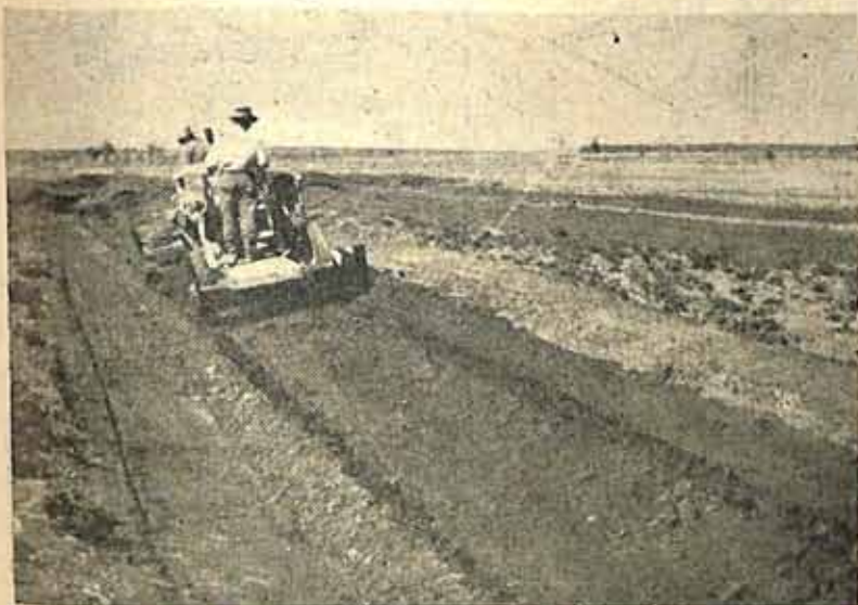
Terraceamento moto-mecanizado, com auxílio de plano atrelado
