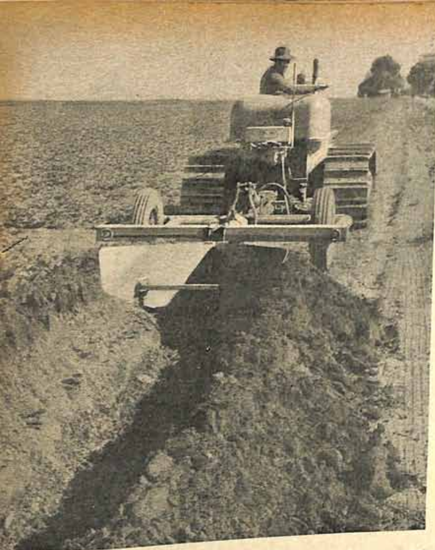
Drenagem por meio de valetadeira, tracionada por trator, construindo valetas abertas.
