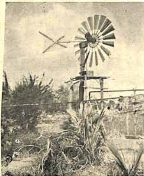
O catavento, em certas regiões do São Francisco, constitui solução para tirar água do sub-solo, destinada aos animais e à pequena irrigação.
