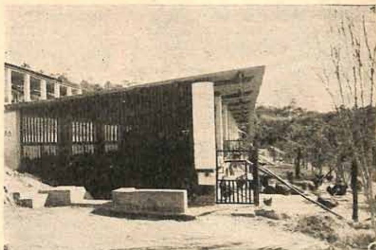
Vista de um galinheiro para 1.000 poedeiras da Granja Tupy, em Itapeceira da Serra. Ripado com parque para aves em recuperação.
