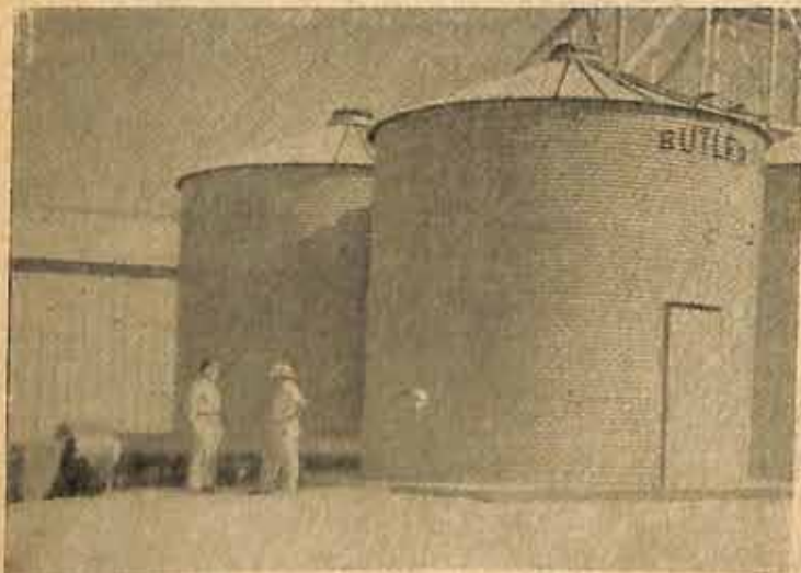
Tipos de silos metálicos elevados
