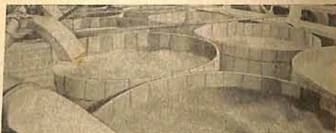
Pormenor do armazenamento de grãos a granel.
