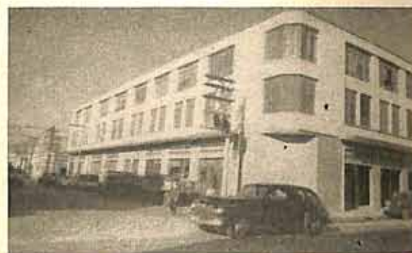
Vista da sede instalada à Rua da Alfândega, 487, em São Paulo, com Entrepósito de Ovos e Câmaras Frigoríficas próprias para estocagem dos ovos no período de safra.
