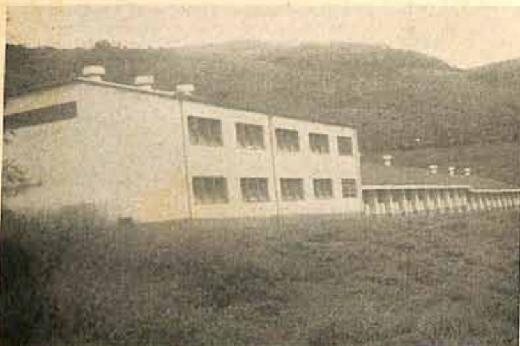
Detalhe do frangueiro na parte em dois andares, notando-se os exaustores na cumieira e as janelas de ventilação controlada. Construção sólida, com piso impermeabilizado e calçada de proteção dos alicerces, a alvenaria de tijolos.
