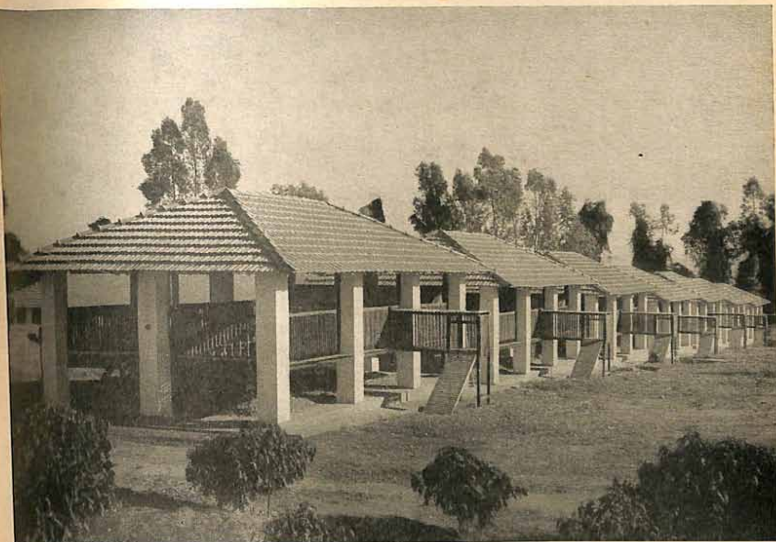
O galinheiro de piso ripado e elevado do solo ainda é preferido pelos avicultores do Estado de São Paulo, principalmente quando visam obter estérco puro, para adubação, como nesta granja consorciada com o café.
