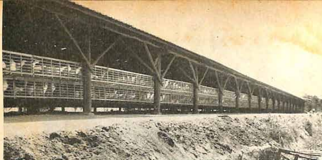
Vista parcial de um galpão para gaiolas. Notem-se os suportes de pé direito, que são de eucalipto tratado, como é todo o vigaamento do telhado. Galpão e gaiolas ao custo médio de Cr$ 180,00 por galinha alojada.
