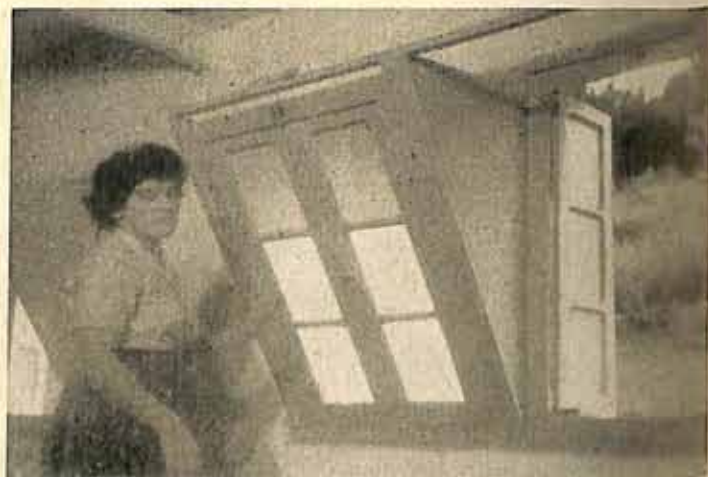
Vistas das janelas de ventilação na parte interna do frangueiro. D. Nedi, esposa do Tenente Bezerra e sua dedicada auxiliar, mostra o funcionamento das janelas em suas diferentes posições, para ativar a ventilação.
