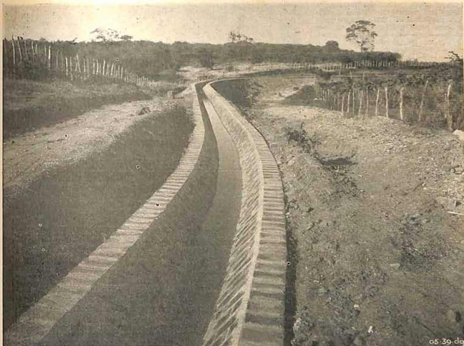
Canal de irrigação secundário, na bacia de irrigação do açude Joaquim Távora.
