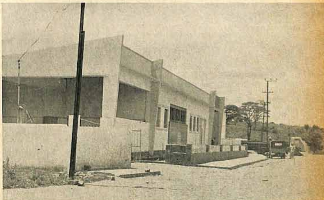
A mesma fachada vista de outro ângulo.
