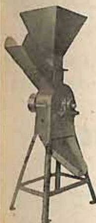
O Moinho a Martelos **Cordeiro** foi idealizado para ser usado em granjas, sítios e pequenas fazendas. Produz fubá de milho fino e grosso — Quirera de milho e arroz — Desintegra o milho com palha e sabugo. O Moinho de Martelos **Cordeiro** é inteiramente metálico e equipado com 14 martelos de ferro cimentado. Capacidade de produção: 30 a 220 kg por hora, de acôrdo com o material a ser moído.
