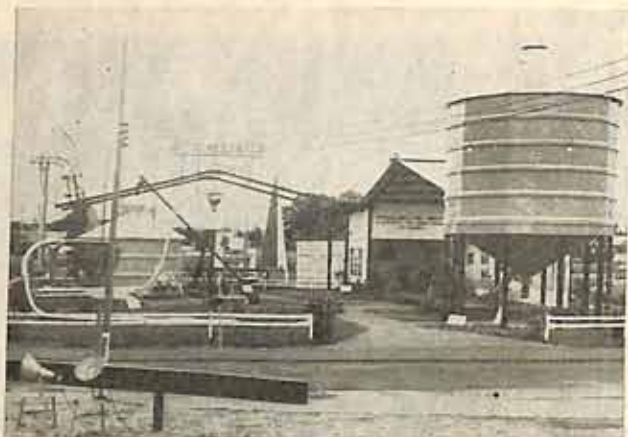
A Metalmecânica S.A. Indústria e Comércio, cuja sede está instalada na Praça Ramos Azevedo, 206 - 3.º andar, apresentou interessante novidade: o silo "Frigieri" MM, que permite ensilar em qualquer lugar da fazenda. Custando menos que um silo de alvenaria, concreto ou metal, podendo ser montado e desmontado em qualquer lugar, não exigindo mão de obra especializada nem instalação fixa. Uma grande contribuição para a solução do problema do forrageamento do gado.
