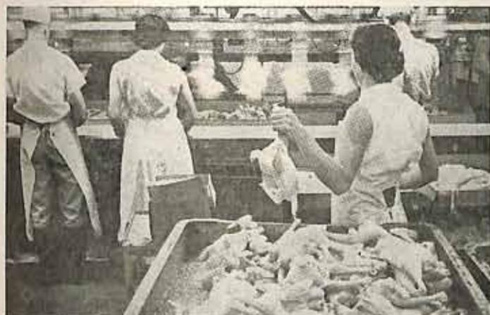
Vista parcial de matadouro avícola, notando-se o tanque de resfriamento com água gelada para retirar rapidamente o calor animal e, com isso, anular ou diminuir sensivelmente o crescimento dos germes que vivem na pele e nas cavidades de evisceração.
