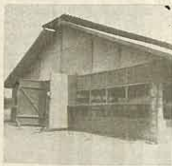
Frente do frangueiro industrial mostrando a porta de acesso, com 2,5 m de largura para entrada de veículos na retirada da "cama". Oitão fechado e basculante para a ventilação, quando necessária. Detalhe do lanternim reto.
