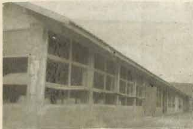
Vista do "frangueiro" de 50x12 metros, com lanternim de cumieira, em fase final de acabamento, mostrando a ampla ventilação e luminosidade.
