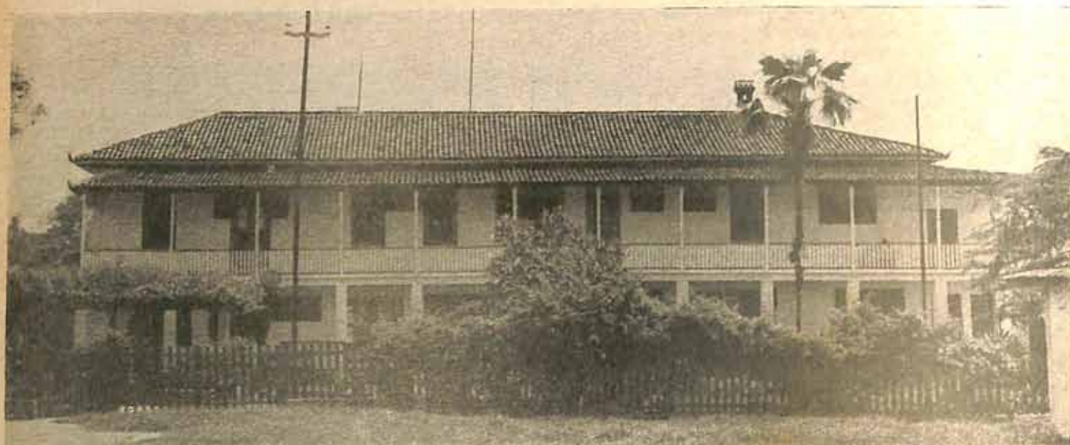
Sede da fazenda, em Calciolândia. Velha construção dos tempos coloniais, contrastando com as modernas diretrizes que se procuram imprimir a propriedade. Seu estilo é conservado desde a reforma feita em 1913 pelo Dr. Donato de Andrade, que desde essa época se dedica à produção de leite. A hospitalidade aqui é uma norma.
