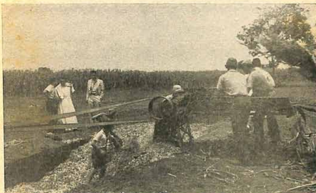
Fase de carregamento do silo.
