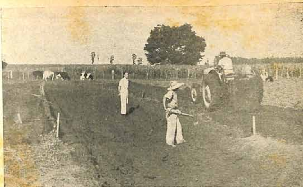
Comêço da escavação de um silo de trincheira para reserva de alimentos no inverno.
