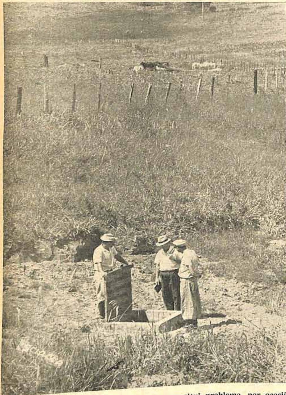
O suprimento de água para o rebanho constitui problema, por ocasião da divisão das invernadas. A Fazenda Jangada, tal como outras, adota o sistema de captação de fontes subterrâneas. Neste clichê aparece, em primeiro plano, o poço de coleta e, ao fundo, o bebedouro para onde a água se escoia, por gravidade.
