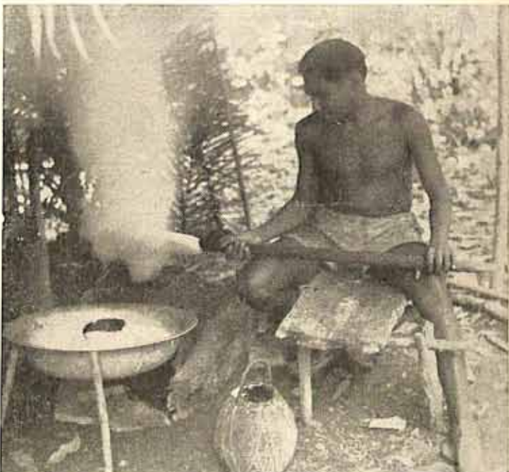
Processo primitivo de condensar a borracha por meio de defumação, ainda hoje muito usado nos seringais da Amazonia em geral.
