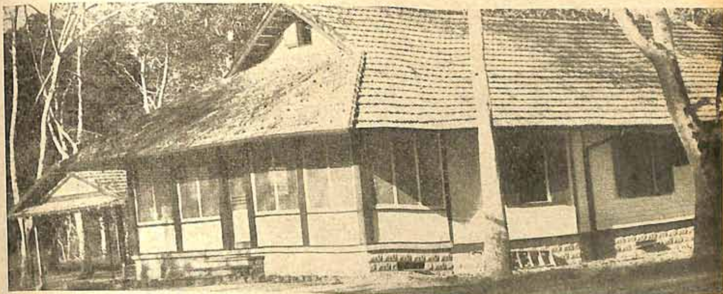
A celebre Casa Seis, para hóspedes de Belterra. Estava em ruínas e foi completamente reformada pela administração atual.
