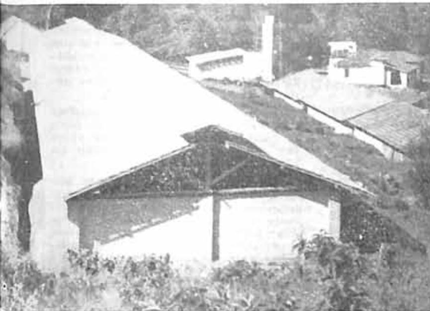
Frangueiro de 2.000 frangos equipado com ventilador contínuo de cumieira (lanternim).
