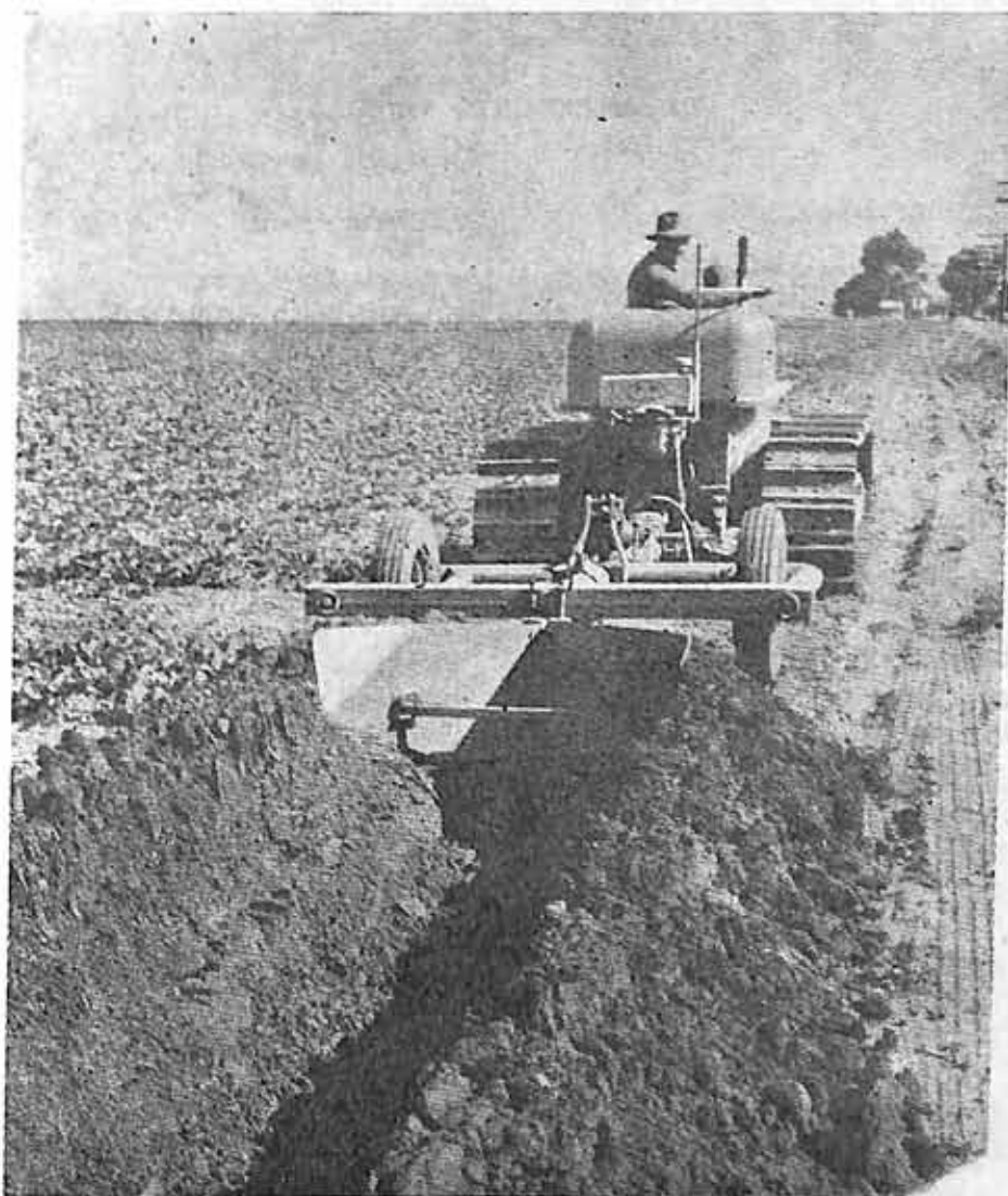
Drenagem feita por meio de «valetadeira» tracionada a trator, na construção de valetas abertas.
