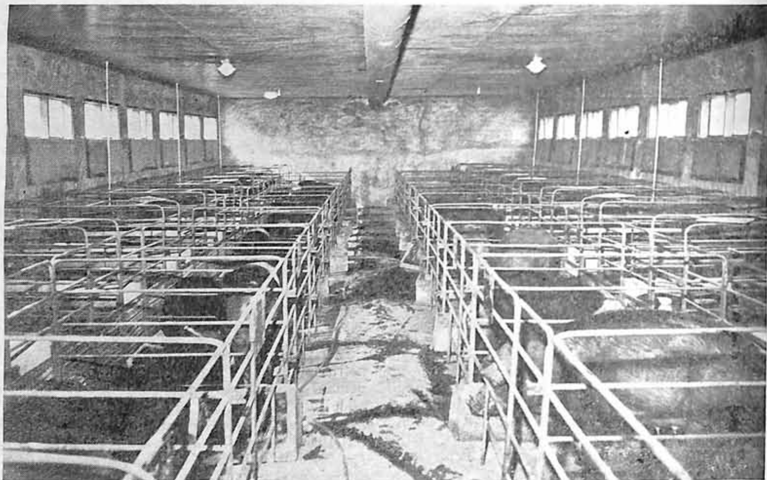
Vista interna da maternidade, com as porcas no recinto de alimentação. Notar, no fôrro, o grande tubo de renovação de ar.
