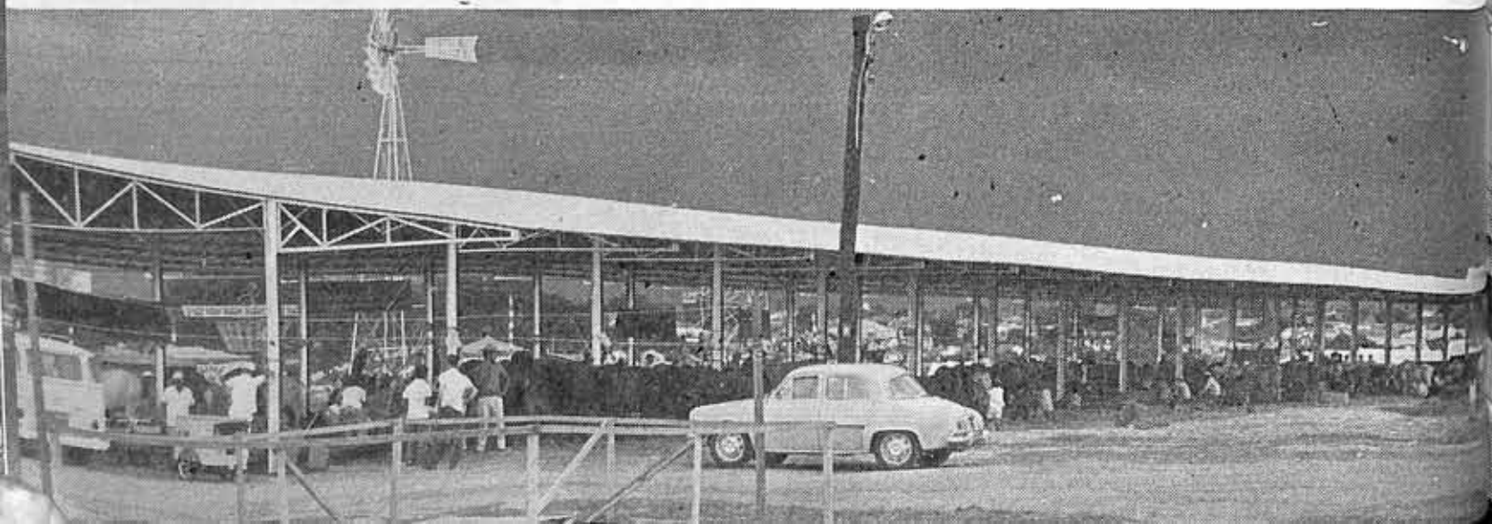
Vista do maior pavilhão de bovinos já construído no Brasil. Comportou 400 bovinos argolados em quatro filas longitudinais. Construído de aço e alumínio, é iluminado por lâmpadas de mercúrio.
