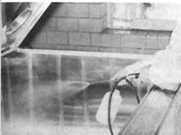
Terminada a lavagem do tanque, faz-se uma pulverização com solução clorada.
