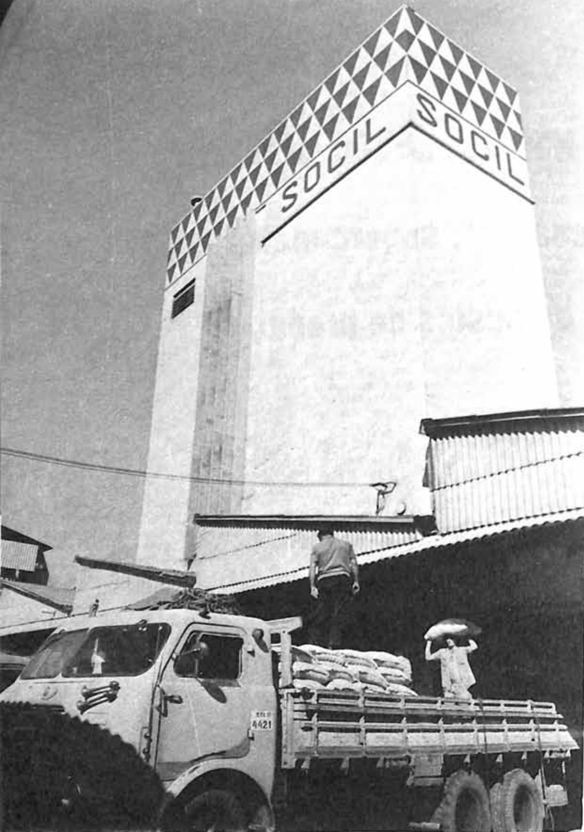
Silos, torre de fabricação e embarque de produtos terminados.
