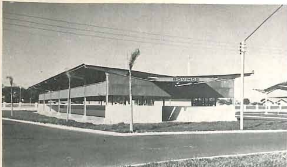
Cinco pavilhões já estão prontos no recinto de exposições que o Sindicato Rural de Araguari está construindo. São de belo aspeto, como se pode verificar pela foto que reproduzimos.
