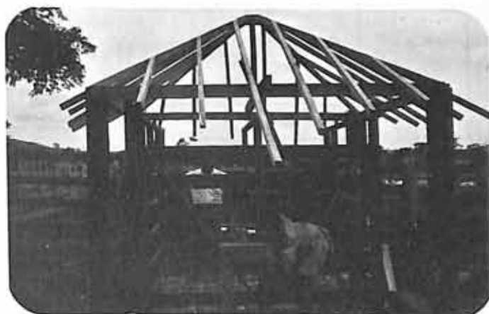
Instalação de balança feita de acordo com as exigências da Condepe.
