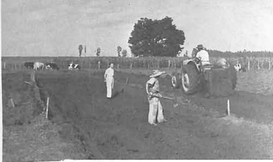
Início de escavação para um silo trincheira.
