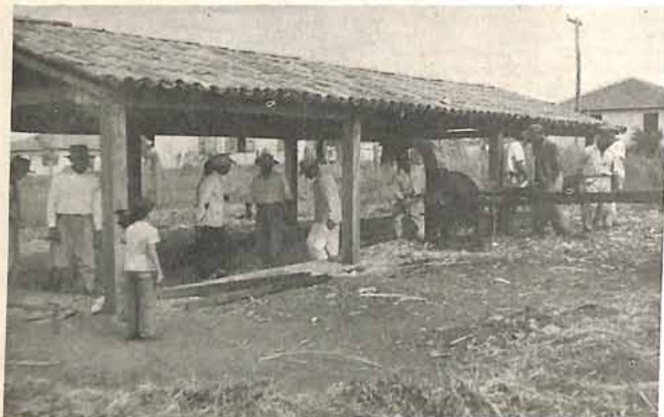
Final de enchimento de um silo de trincheira com a capacidade de 20 toneladas.
