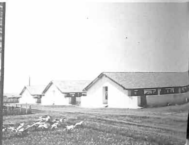
Pavilhões de terminação.
