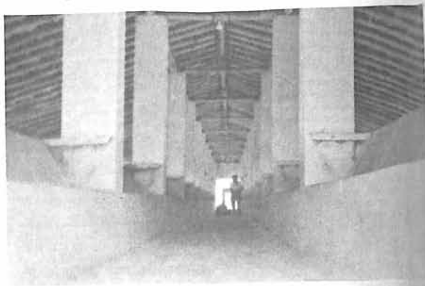
Tomada interna de um pavilhão de terminação.
